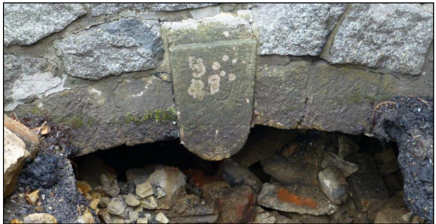
Mühlgraben-Gewölbe mit dem Schlußstein C G M 1837, die Initialen sind leider stark verwittert
