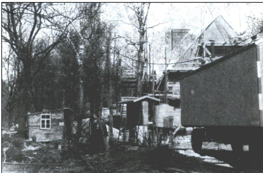
Scheinbar chaotisch: während der Arbeiten zum Wiederaufbau 1972; Foto: Rudolf Limpach
