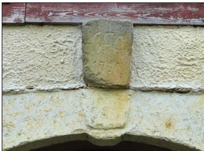
Schlussstein über der Wohnhaustür mit G F A 1760
