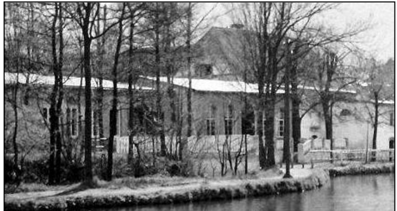
Saalanbau und Gesellschaftszimmer; rechts das Wohnhaus und der Wasserrad-Überbau
