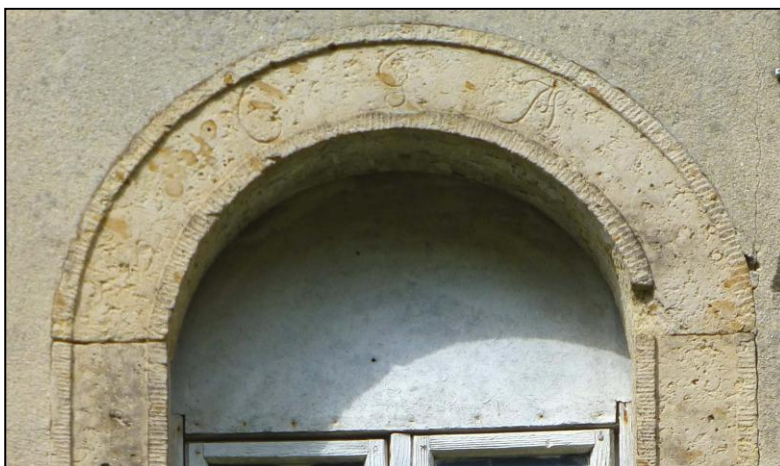
Der monolithische Sandsteinbogen am Giebel des südlichen Wohnhaus-Anbaues mit Mißbachs Initialen C G M
