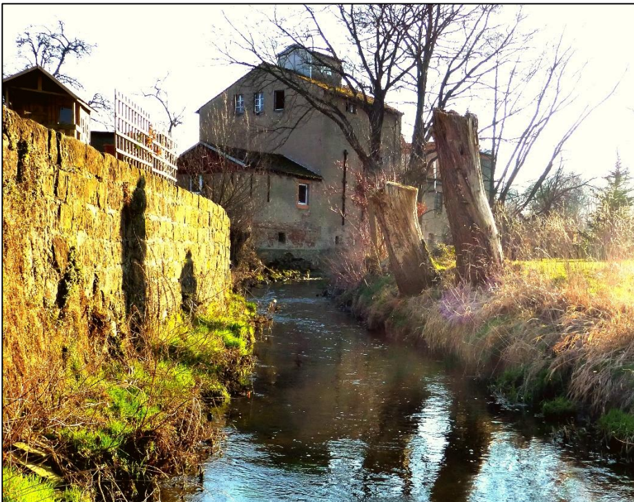
Die Lotzdorfer Rasenmühle 2016 mit dem Untergraben (Mühlgraben-Abschnitt unterhalb des Wasserrades)
