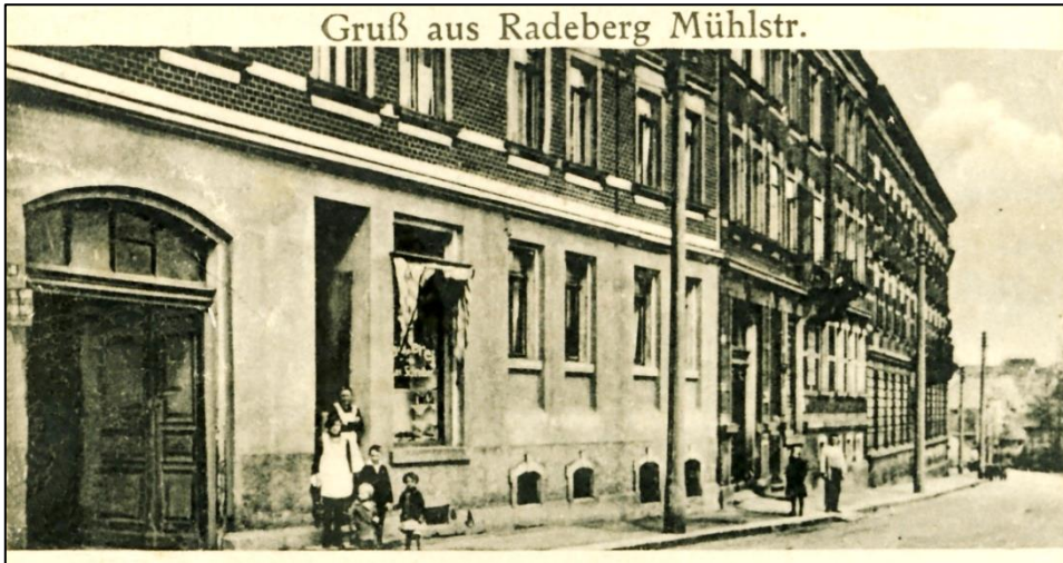
Typische Ziegel-Bauweise von bürgerlichen Wohngebäuden um 1900: Erdgeschoss Ziegelmauerwerk verputzt, Obergeschosse Außenfassaden mit Klinkern verblendet. Beispiele: Mühlstraße 18 und 19 Radeberg.
