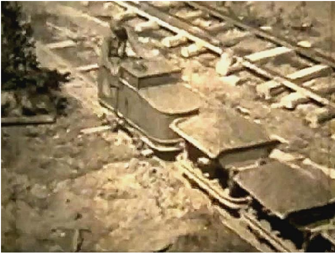
Ein befüllter Feldbahn-Zug auf dem Wege zur Ziegelei.
