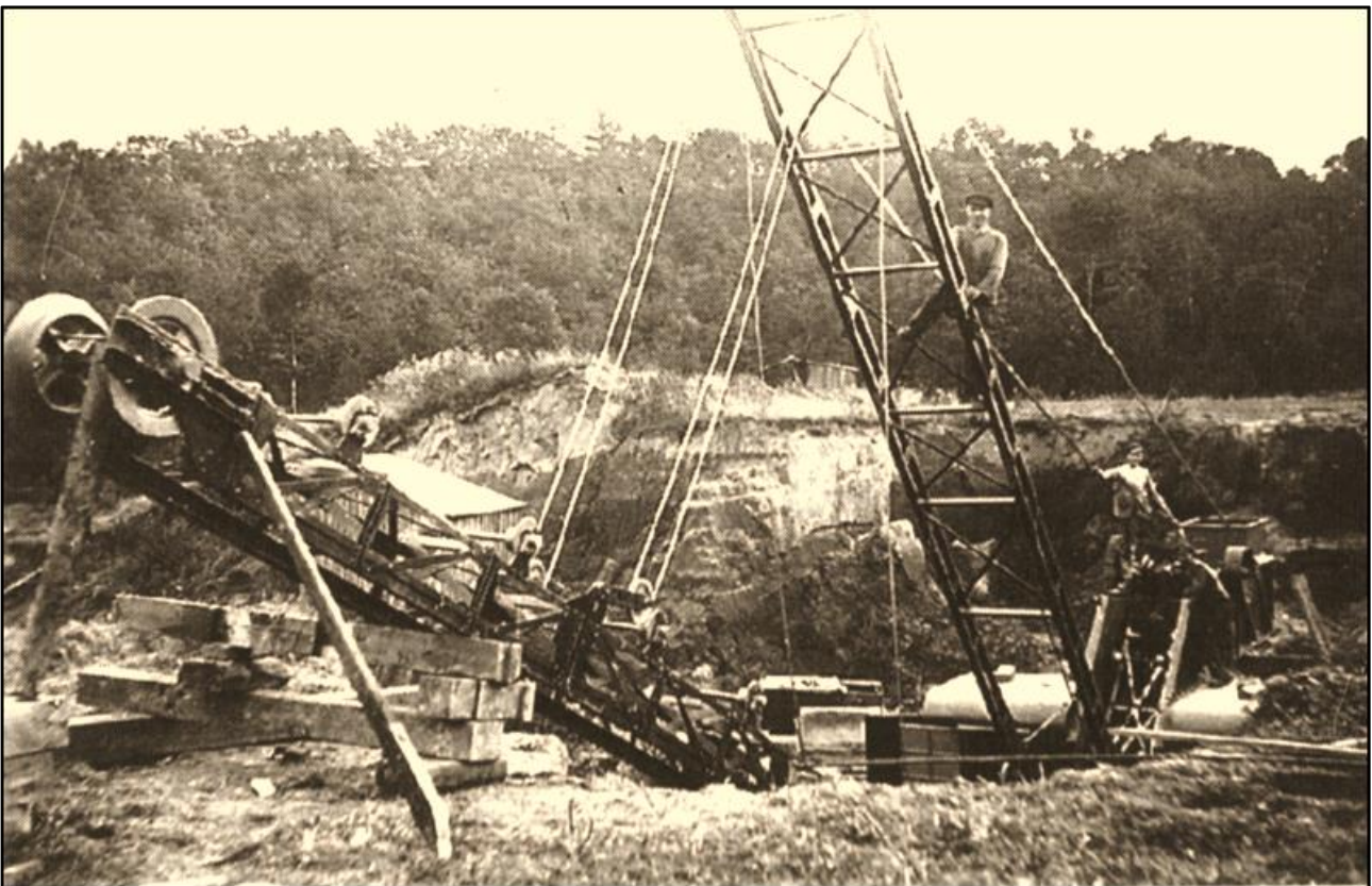
Das Umsetzen des Baggers sowie die Wechsel vom Hoch- zum Tiefschnitt und umgekehrt waren schwierig und aufwändig. Quelle: Lumpe
