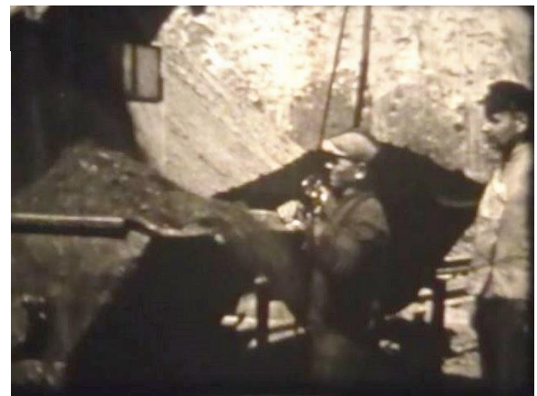
Rechts oben die Diesel-Lokomotive, unten das Leeren des Bagger-Vorratsbehälters direkt in die Feldbahn-Wagen mittels Zug-Klappe. Die leeren Wagen mussten mit Muskelkraft unter die Klappe geschoben werden, so dass nacheinander ein voller Zug zusammengestellt werden konnte.
