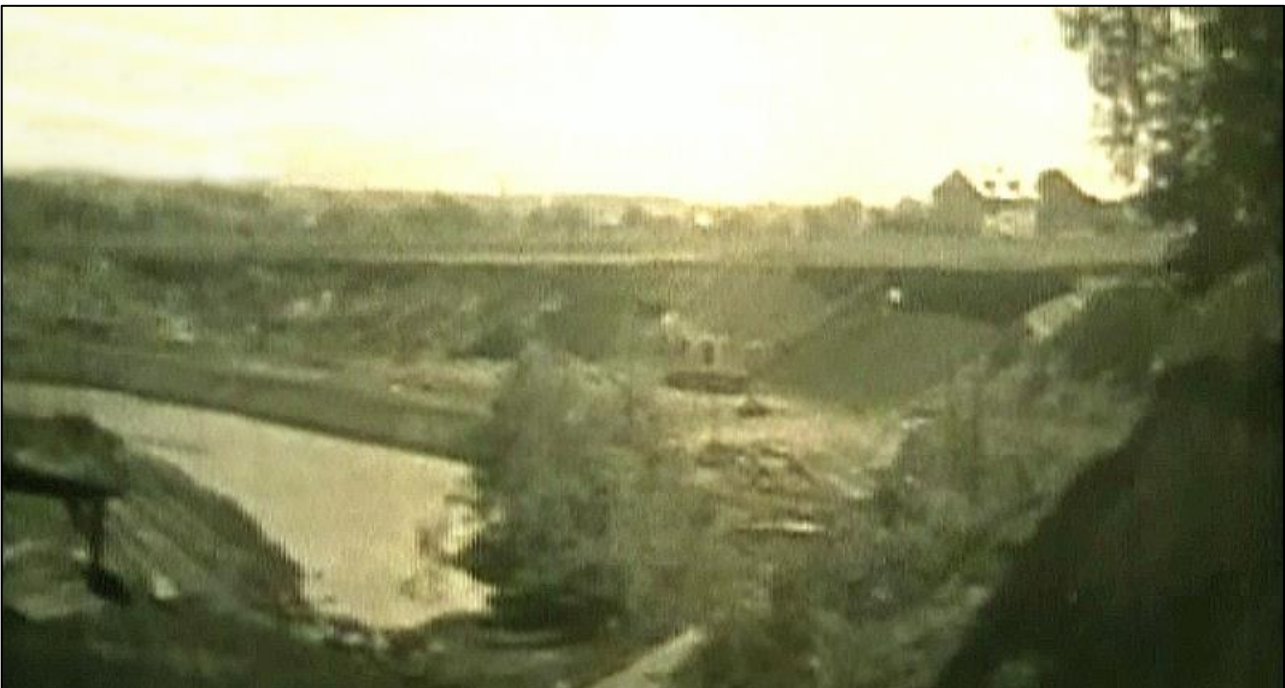
Die Tongrube hat hier bereits 2 Ebenen und ist in Richtung Westen „gewandert“. Im unteren Grubenbereich, der im Bagger-Tiefschnitt entstand, füllt sich der Ziegeleiteich mit Grundwasser. Etwa in Bildmitte auf der Zwischen-Ebene ist der moderne Eimerkettenbagger zu erkennen, hier im Hochschnitt arbeitend. Rechts oben das damals letzte Wohnhaus auf der Badstraße.
