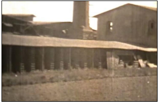
Trockenschuppen und Maschinenhaus
