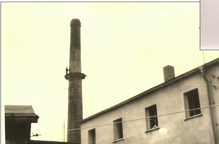
Reparatur-Arbeiten am Schornstein mit einem etwas „abenteuerlichen“ Behelfsgerüst
