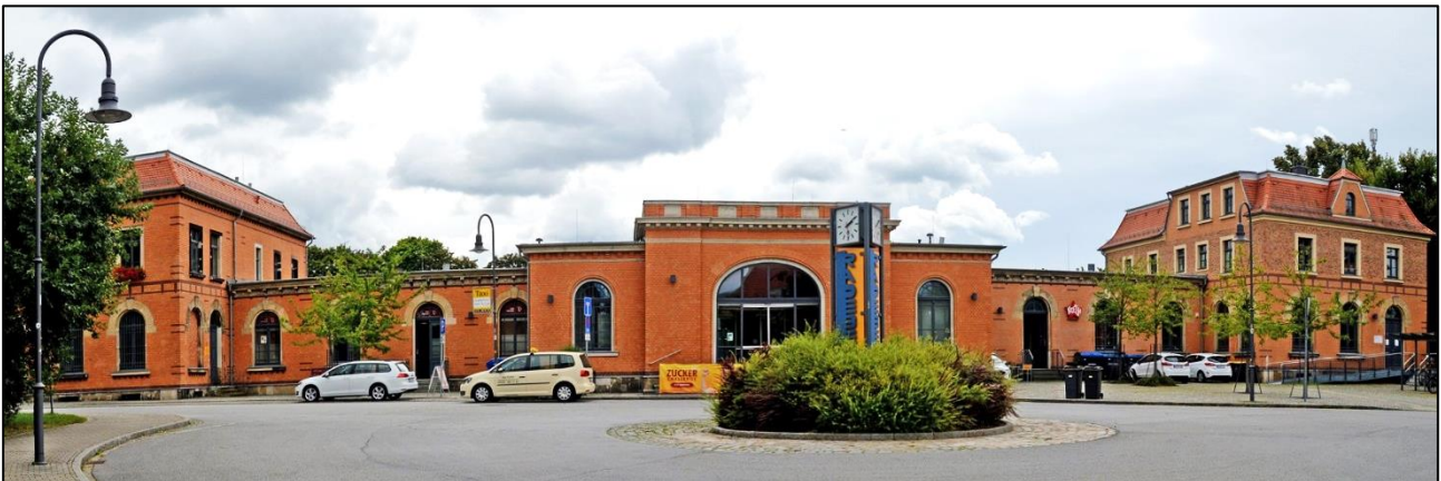
1897 / 98 entstand der repräsentative, durch die Mittelhalle und die symmetrisch angeordneten Betriebsgebäude-Teile geprägte Neubau des Radeberger Bahnhofes in Klinker-Bauweise. Diese sicherte dem gesamten Gebäude-Komplex Langlebigkeit und Witterungs-Stabilität. Foto: Katja Fissel; Redaktion Heimatzeitung „die Radeberger“; August 2020.
