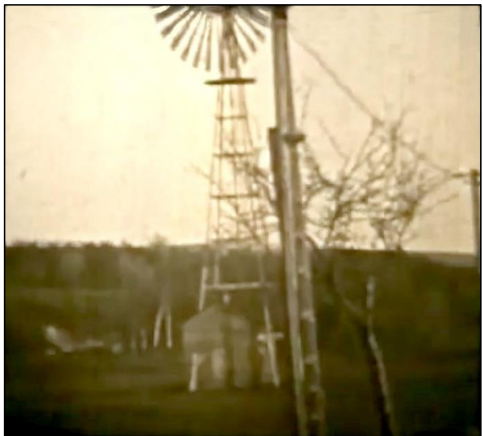
Das erste Windkraftrad der Ziegelei. Mit ihm wurde auf mechanischem Wege (Kurbeltrieb – Pumpenstange (oder -Seil) – Kolbenpumpe) das Grundwasser aus dem Ziegelei-Teich abgepumpt bzw. der Wasserspiegel konstant gehalten.
