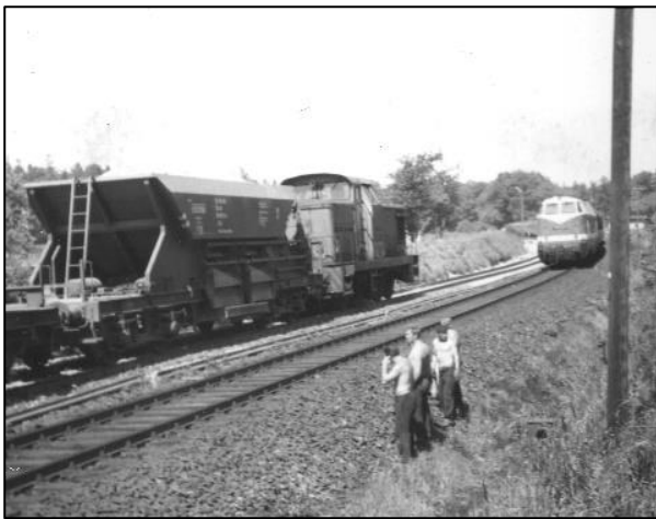
Probefahrt auf dem 1975 fertiggestellten südlichen erneuerten Gleis (links im Bild). Ein von einer Diesellok V 118 (bis 1975: BR V 180) gezogener Personenzug kommt in Richtung Radeberg entgegen.
