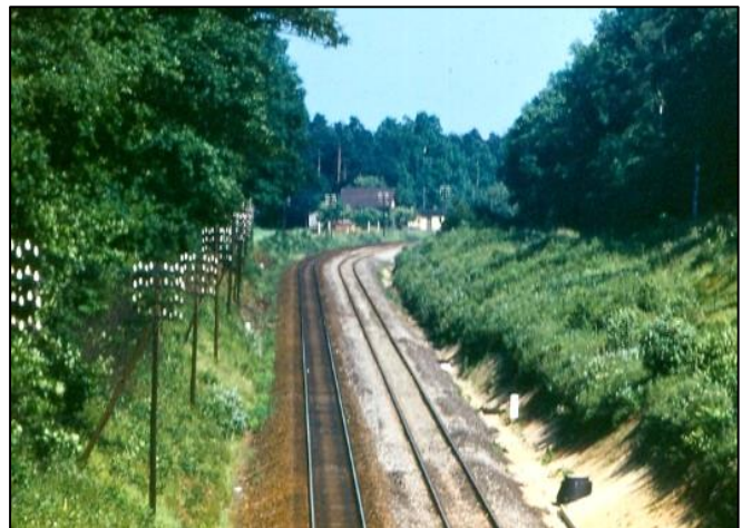
Blick von der ersten Brücke (Nachtflügel) zum Lotzdorfer Block. Beide Gleise sind wieder voll belastbar. Rechts im Bild, am noch hellen Schotterbett erkennbar, das 1975 neu verlegte südliche Gleis. Foto 1975
