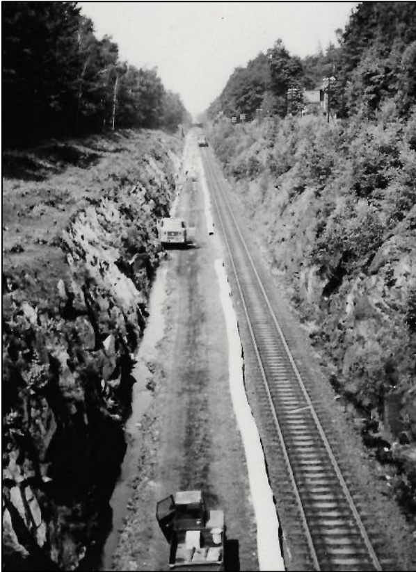
Oberes Bild: Bahnarbeiter beim Verlegen des neuen, ausgetauschten südlichen Gleises, 1974/75
