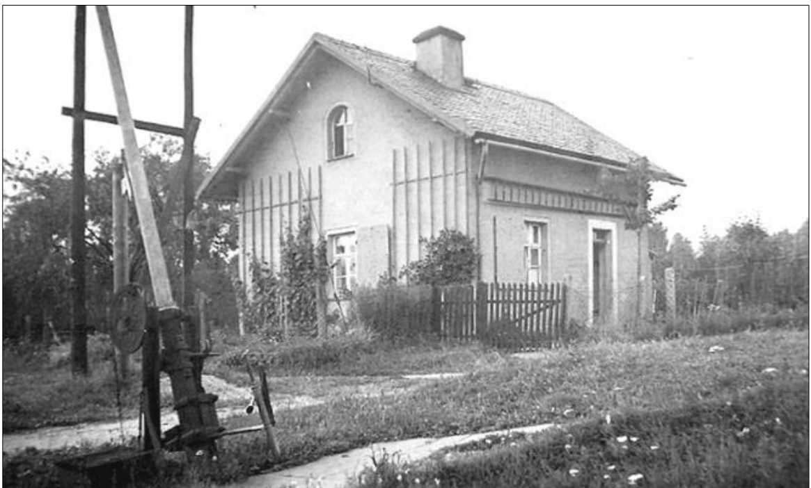
Das bescheidene und bis zur Stilllegung des Lotzdorfer Blockes am 17.6.1975 stets gepflegte Wohnhaus, in dem die Blockwärterfamilie Maximilian Drobny 45 Jahre, von 1930 bis zum 9. August 1975, wohnte. Danach stand das Haus leer und verfiel.
