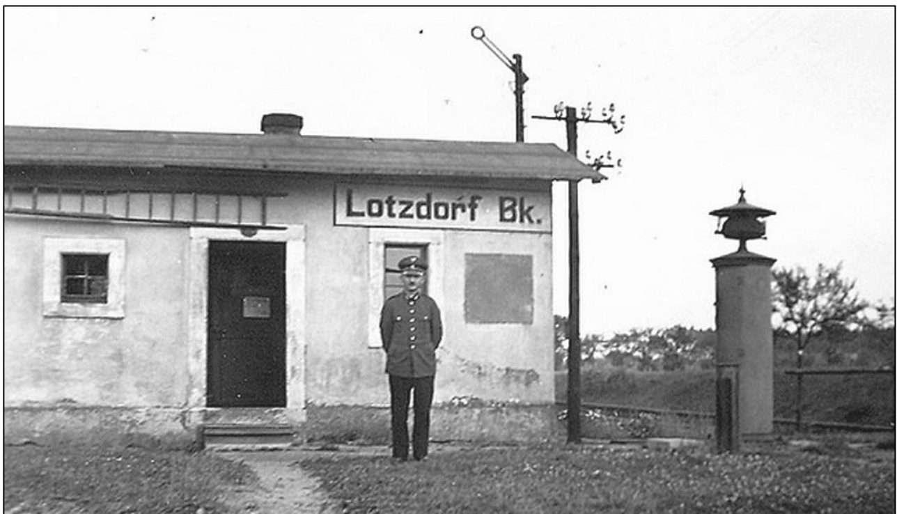
Das kleine Dienstgebäude der Lotzdorfer Blockstelle mit Blockwärter Maximilian Drobny und dem originalen Lätewerk. Dieses wurde hier bereits elektrisch angesteuert. Das zum Block gehörende Hauptsignal steht auf „Freie Fahrt“ in Richtung Langebrück, d.h. der nächste Streckenabschnitt darf befahren werden. Foto um 1930
