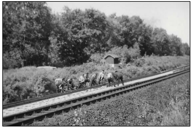
Oberes Bild: Bahnarbeiter beim Verlegen des neuen, ausgetauschten südlichen Gleises, 1974/75
