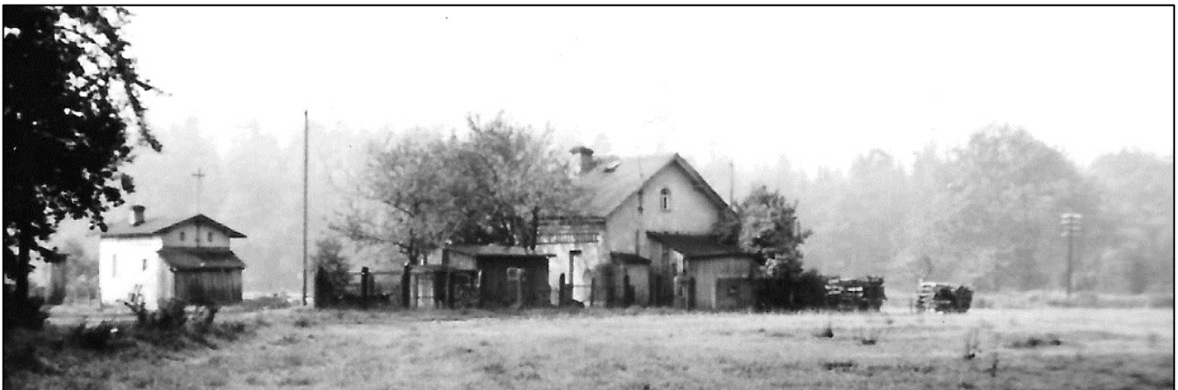
Das Blockstellen-Areal 1972, aus Richtung Lotzdorf gesehen. Die Gleise liegen bei dieser Ansicht hinter den Gebäuden.
